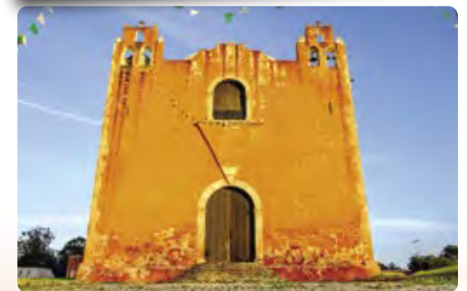
Een karakteristieke koloniale kerk in Santa Elena
